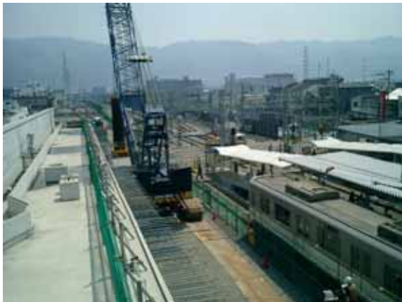
写真-3 列車近接部の施工
