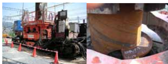
写真-1 全旋回ケーシングジャッキ
