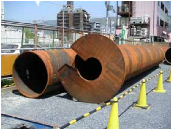
写真-2 杭先端写真
