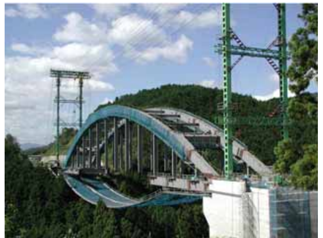
写真 - 3 補剛桁部架設（仮2ヒンジ時）
