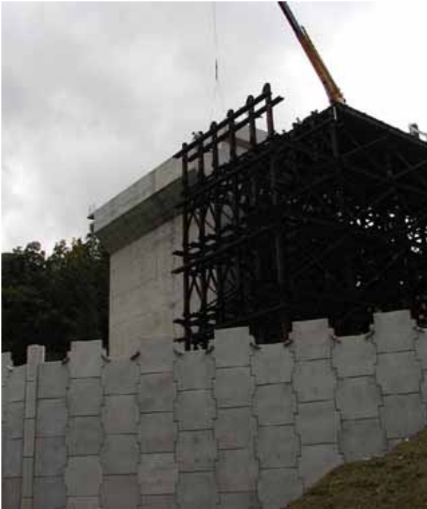
写真 - 1 A1橋台構築を終え撤去中の仮棧橋
