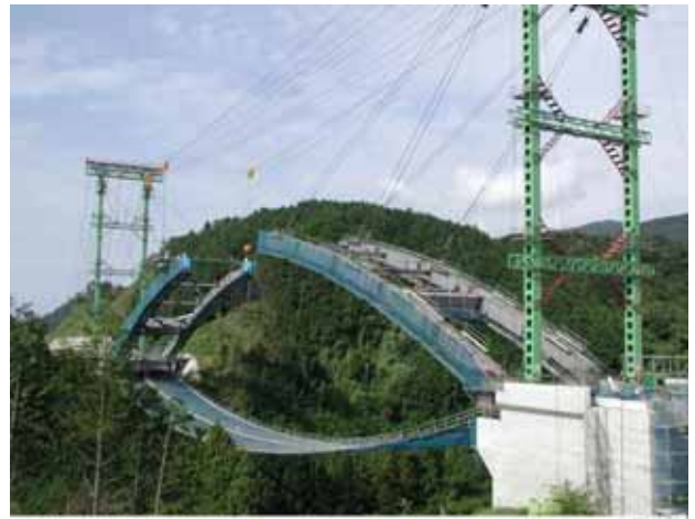
写真 - 2 アーチ部架設（斜吊り時）
